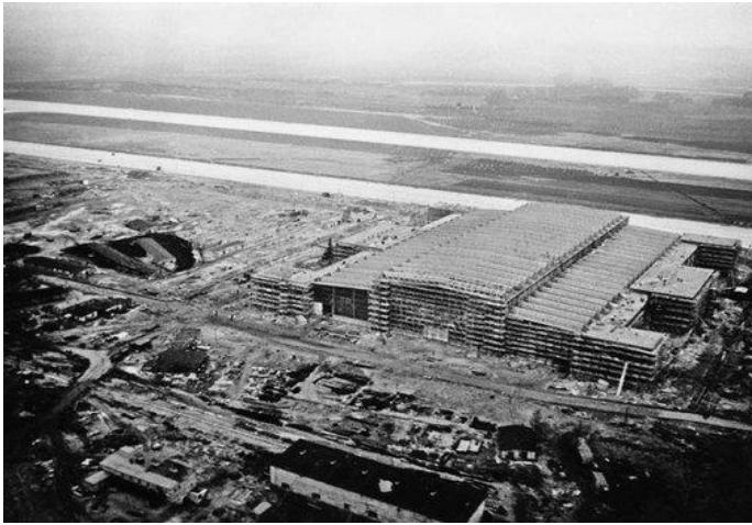
Neubau Halle 219 Foto: Mdf AG Dresden
